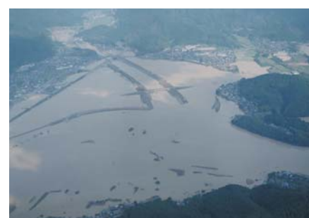
台風23号による由良川(ゆらがわ)のはん濫状況(福知山市大江町) 提供:国土交通省 福知山河川国道事務所
