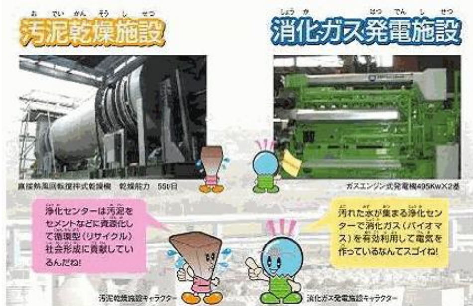
図 1-5 府営木津川流域下水道洛南浄化センターの消化ガス発電施設と汚泥乾燥施設
