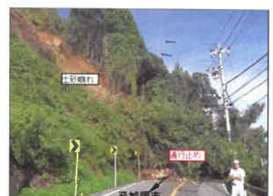
【被災の様子 平成25年9月】
