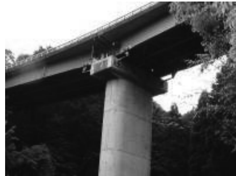
橋梁耐震対策
