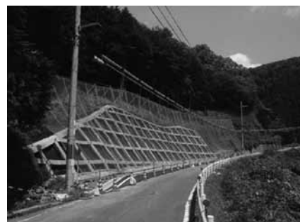
和東井手線（井手町多賀）の防災対策
