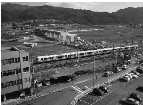
亀岡園部線（保津南工区 亀岡市）
