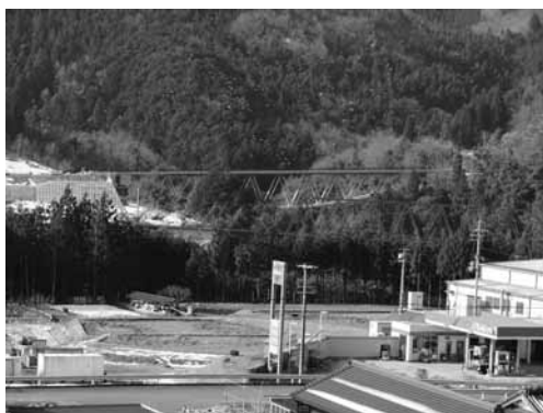
広野綾部線（(仮)大簾川橋 京丹波町）
