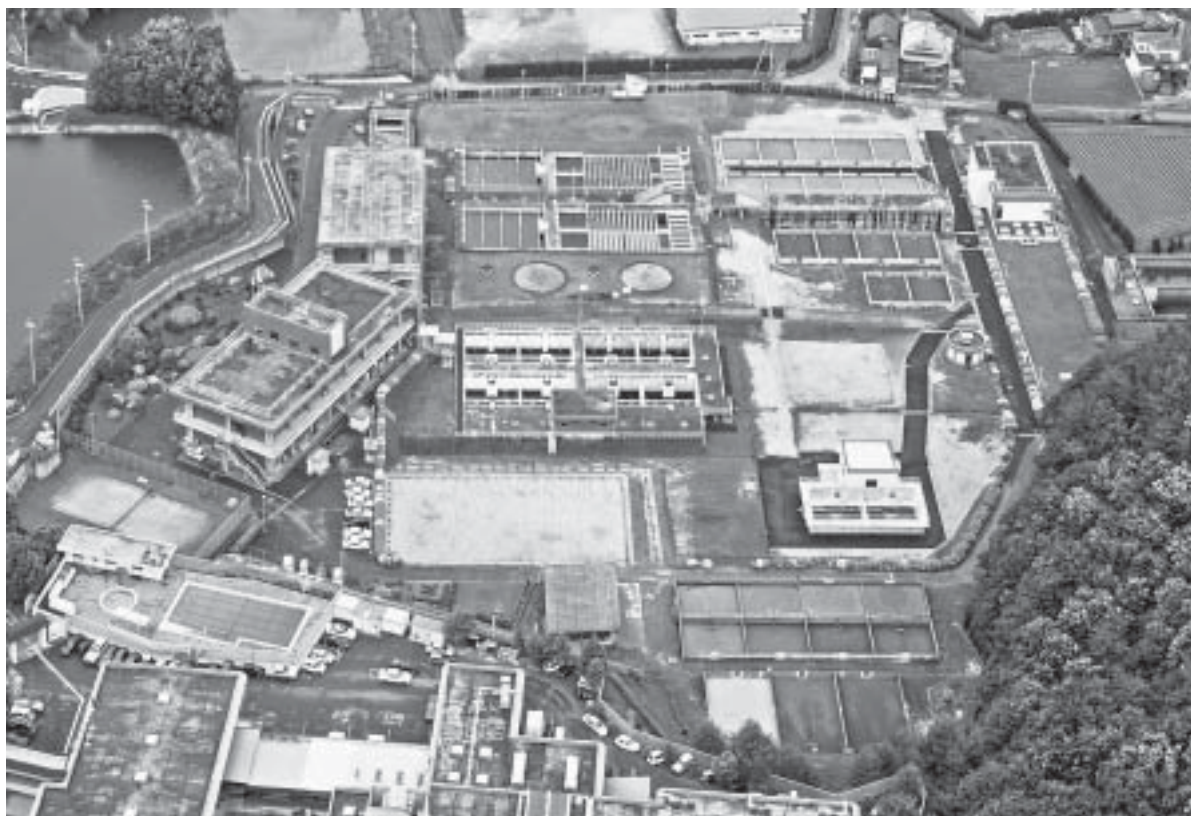
【写真 3.2.2】 木津浄水場全景（京都府企業局提供）
