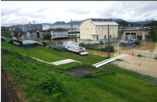
福知山市(弘法川樋門付近:左岸35.2k)
