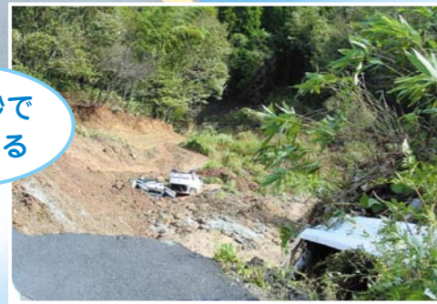
寸断された国道178号(京丹後市久美浜町)
