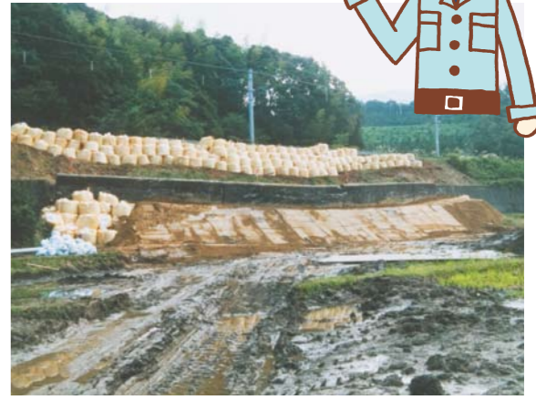
一日も早い運転再開をめざした復旧工事 (KTR宮村駅付近)
