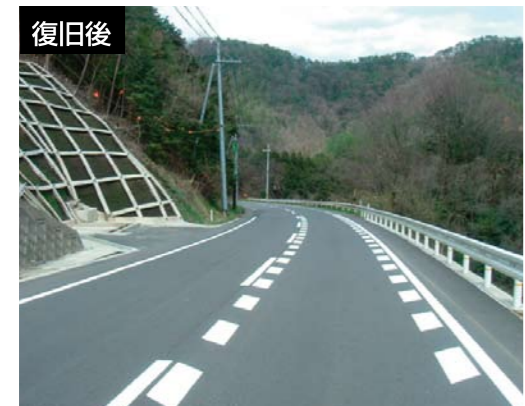
復旧工事完了
