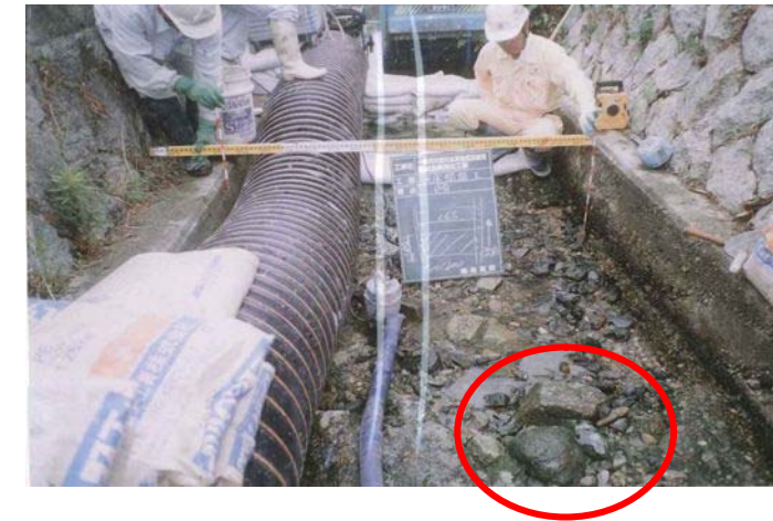
河床コンクリート背面の礫 ( \phi 200\text{mm} 程度以下)
