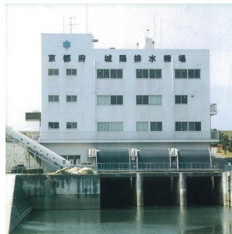
城陽排水機場
