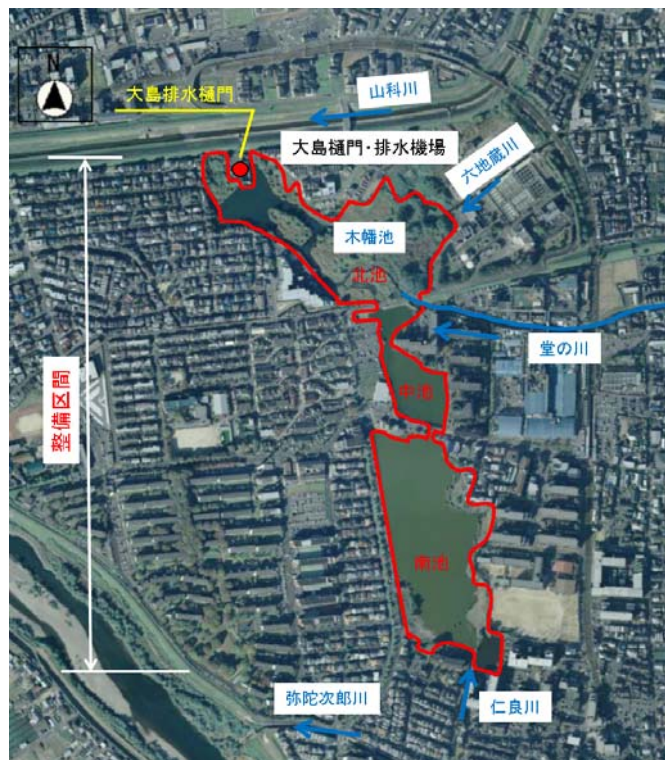
図 2-31 堂の川(木幡池)の整備区間
