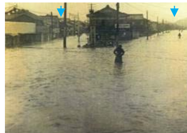
国道27号線西舞鶴駅前
