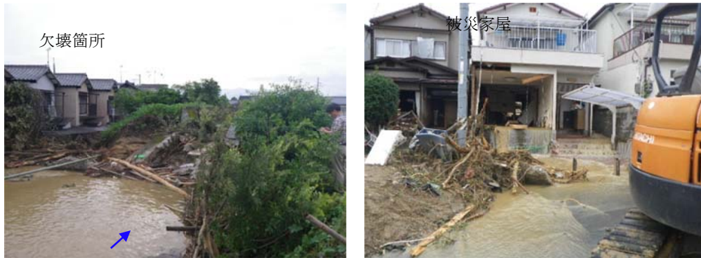
図-3.4 弥陀次郎川破堤箇所での流木等の状況(8月14日)
