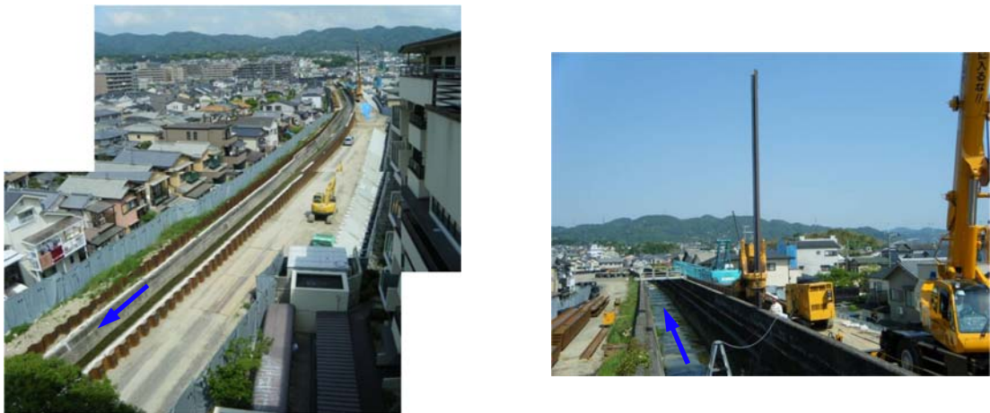
図-8.11 鋼矢板の打設状況
