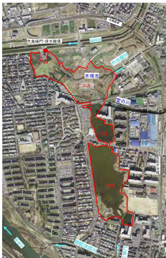
図 2-25 堂の川(木幡池)の整備区間
