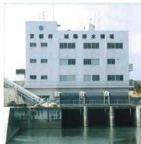
城陽排水機場
