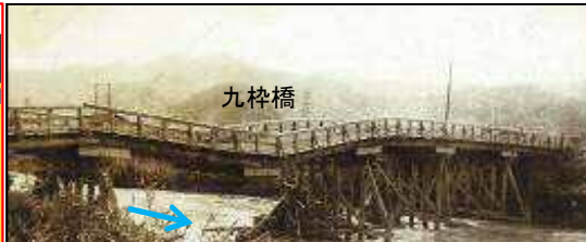
昭和28年台風13号による被害 『舞鶴市全域: 浸水家屋 約19,000戸、浸水面積 825ha』
