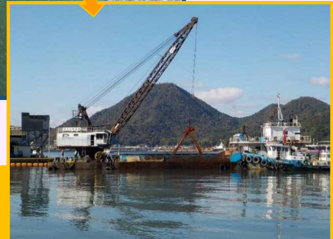
グラブ浚渫船による浚渫の状況
