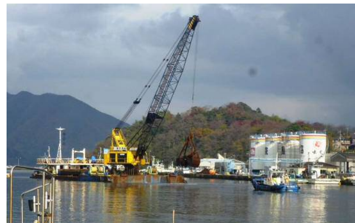
河口部掘削状況
