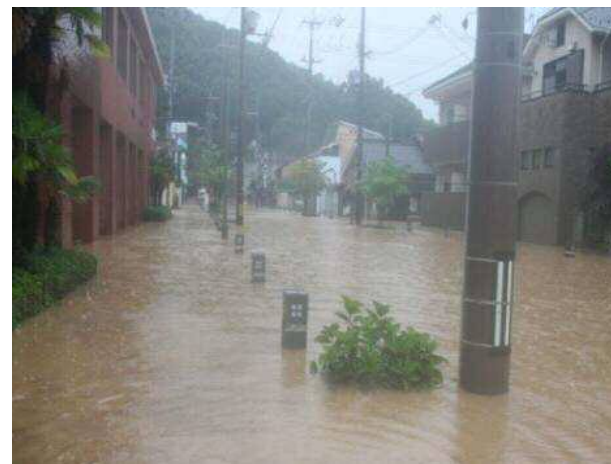
高野川左岸:市街地浸水状況
