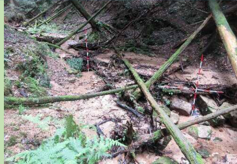
流木の撤去及び捕捉施設の設置(実施前)
