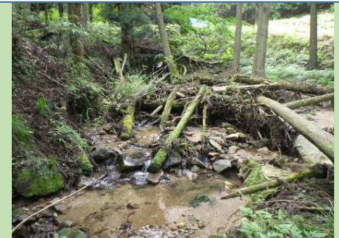
危険木の撤去(実施前)
