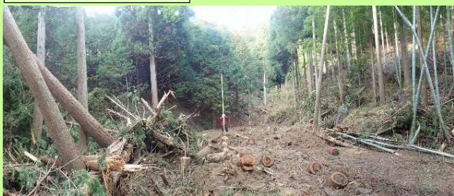
治山ダム工箇所
