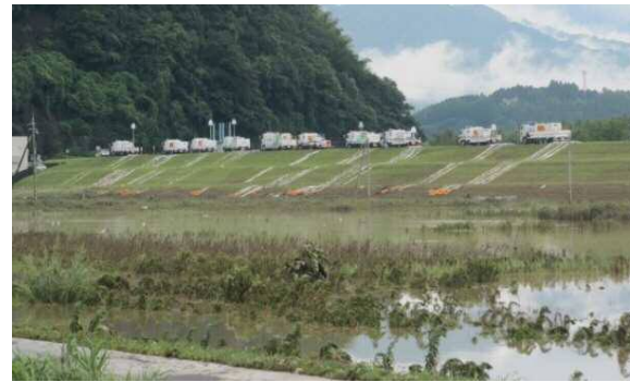
近畿地方整備局の排水ポンプ車稼働状況 (H30年7月豪雨・福知山市荒河排水機場)
