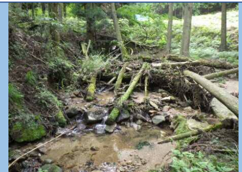
危険木の撤去(実施前)
