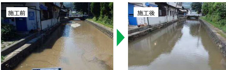
図-1 河道掘削施工イメージ
