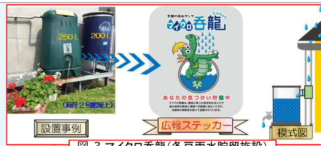
図-3 マイクロ呑龍(各戸雨水貯留施設)
