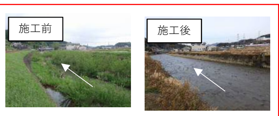
図-1 維持掘削・河道内樹木伐採
