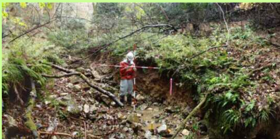
溪流荒廃状況
