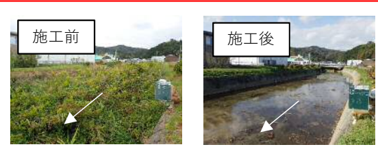
図-1 維持掘削・河道内樹木伐採
