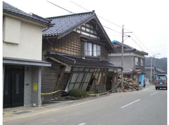
（建築物の被害の状況<門前町道下地区>）
