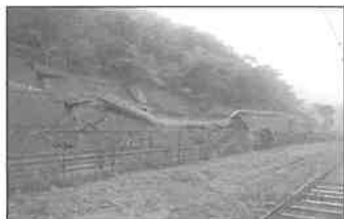
↑国道27号（舞鶴市真倉）の法面崩壊
