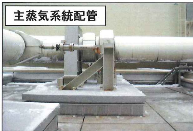
配管サポートの耐震性補強(例)
