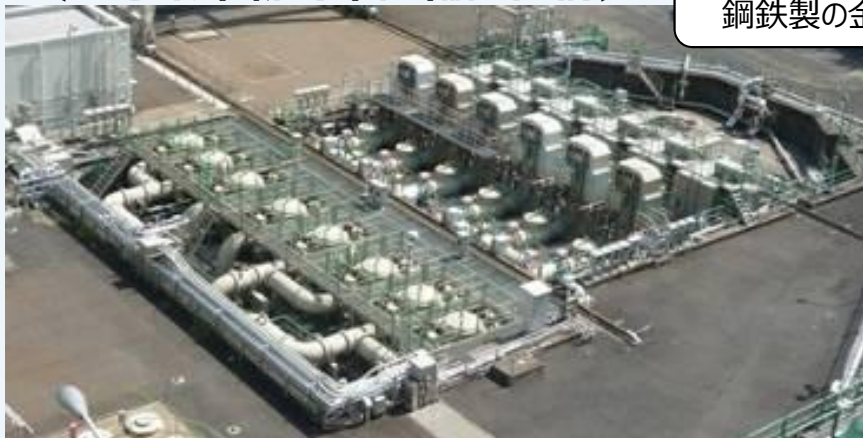
〔竜巻飛来物対策設備設置前〕
