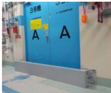
扉への堰の設置
