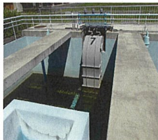
木津浄水場ろ過池改造 （クリプトスポリジウム等対策）
