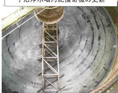
宇治浄水場汚泥掻寄機の更新
