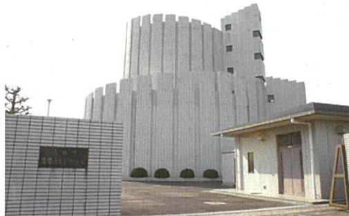
美濃山高区配水場
