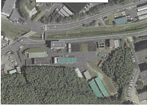
美濃山浄水場
