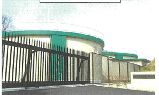
南田辺北配水池
