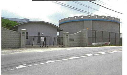
田辺高区配水池
