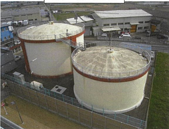
第3・第4配水池
