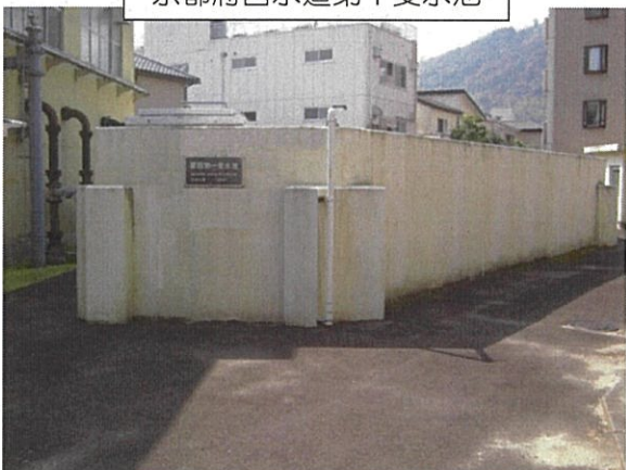
京都府営水道第1 受水池
