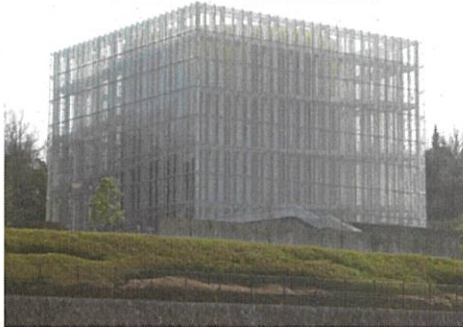
華の塔配水池
