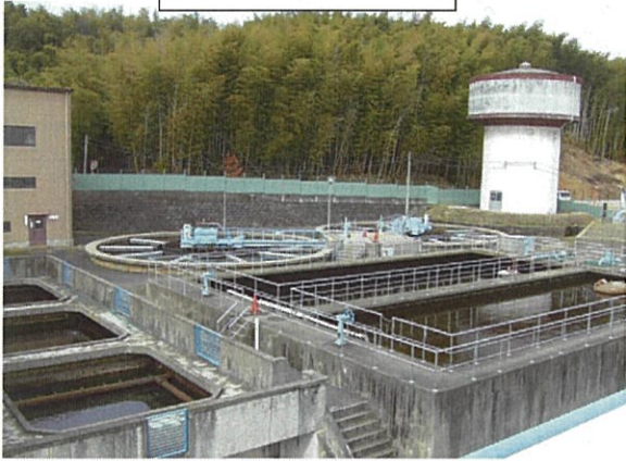
物集女西浄水場
