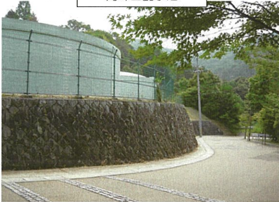
高峰山配水池
