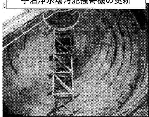
宇治浄水場汚泥掻寄機の更新
