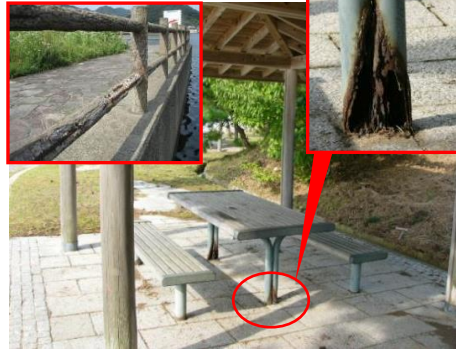
□施設が壊れている
