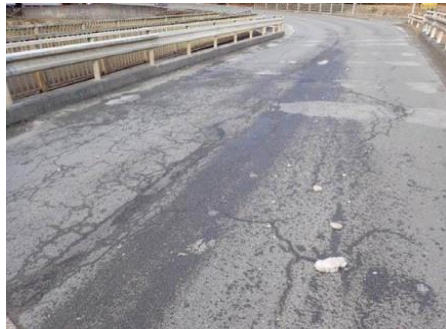
舗装がひび割れしている
