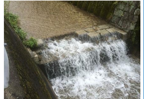
□ 構造物が一部壊れている
