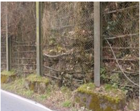
□ 落石を止める網や柵が壊れている
