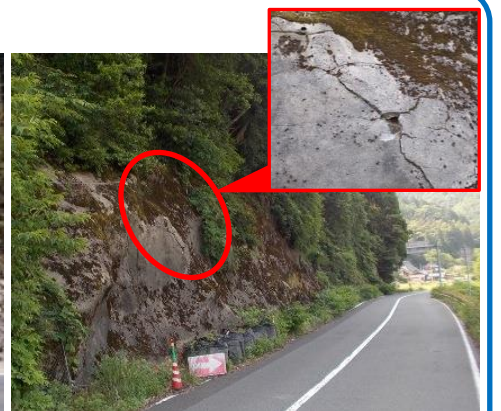
□ のり面にひび割れがある
