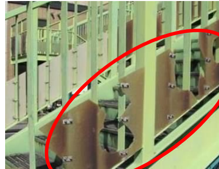
歩道橋のパネルが壊れている
