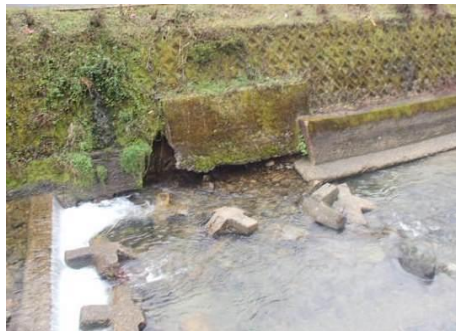
□ 護岸が崩れかけている
