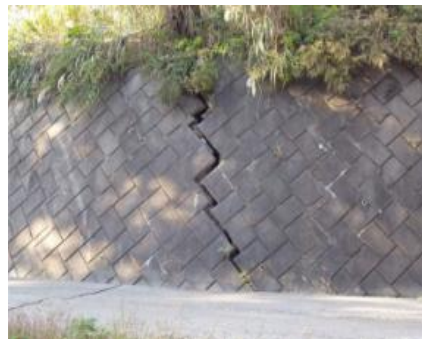
□構造物が壊れている
