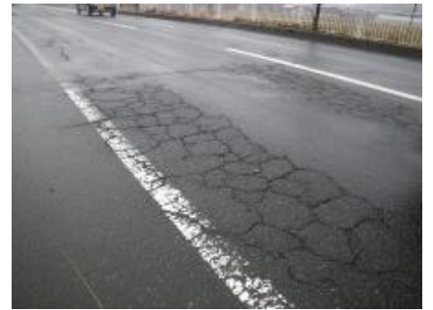
□ 舗装がひび割れしている
