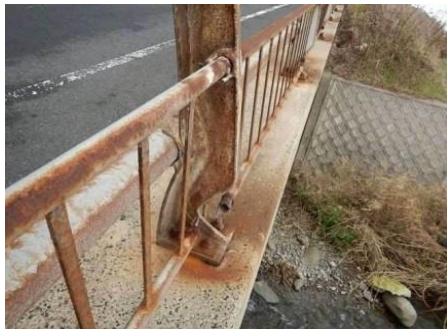
柵が錆びている
