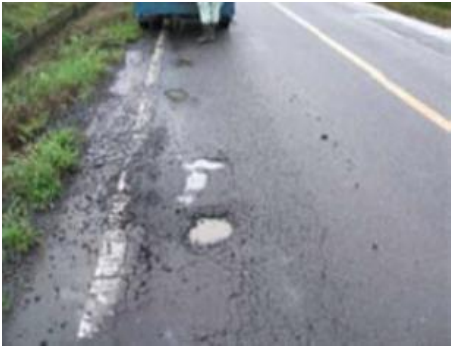
□ 舗装の一部に穴が開いている
