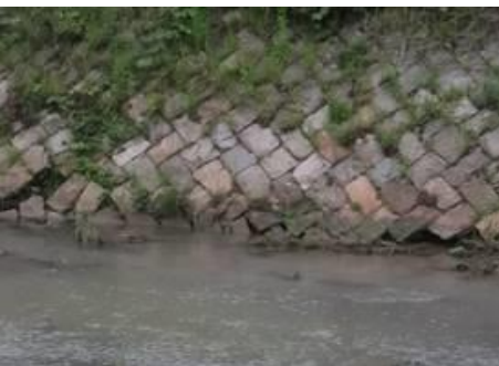
□ 護岸が崩れかけている
