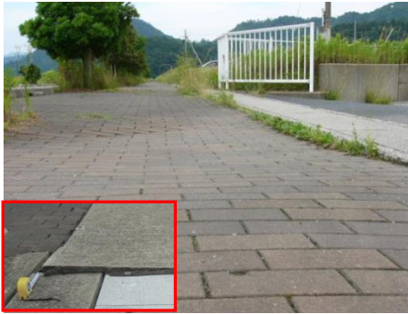
□歩道舗装が沈んでいる
