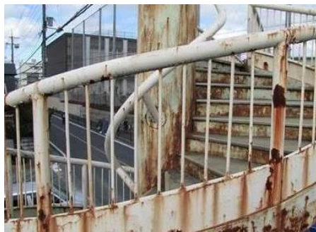
歩道橋が錆びている
