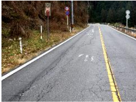
□ 舗装が波打っている
