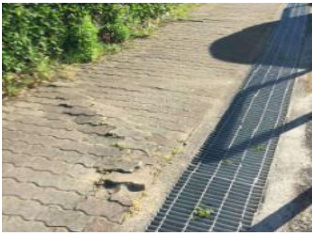
□園路に段差ができている
