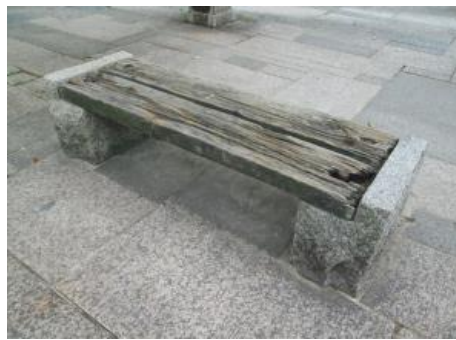
□木製施設が腐っている
