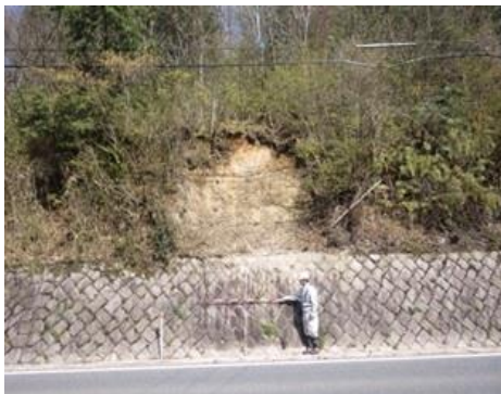
□ のり面が崩れている
