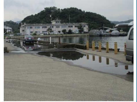
□舗装が沈んでいる
