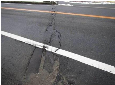
継ぎ目に段差やひび割れがある
