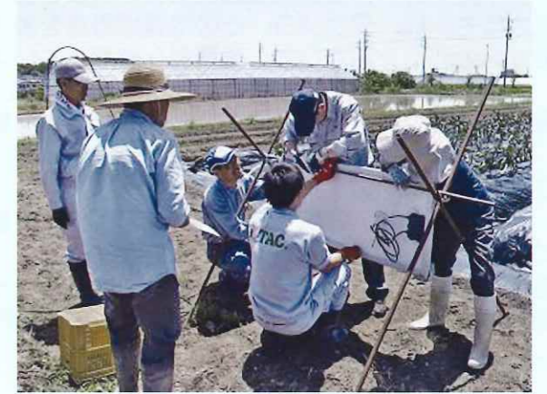
ソーラーパネル設置
