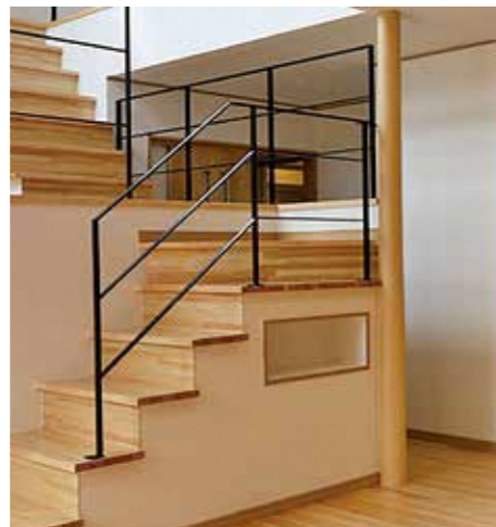
施工例 飾り柱
