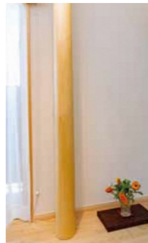
施工例 飾り柱
