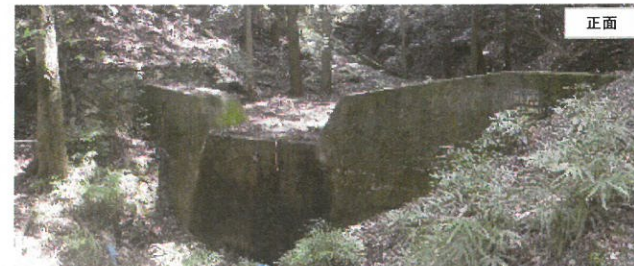
② 昭和58年度施工治山ダム工(正面及び上流の堆砂状況)
