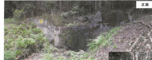
① 昭和50年度施工治山ダム工(正面及び上流の堆砂状況)
