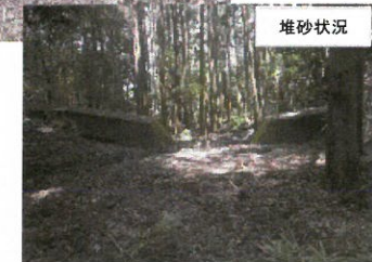
② 昭和58年度施工治山ダム工(正面及び上流の堆砂状況)
