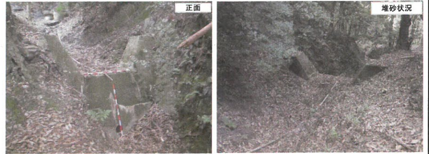
① 昭和50年度施工治山ダム工(正面及び上流の堆砂状況)
