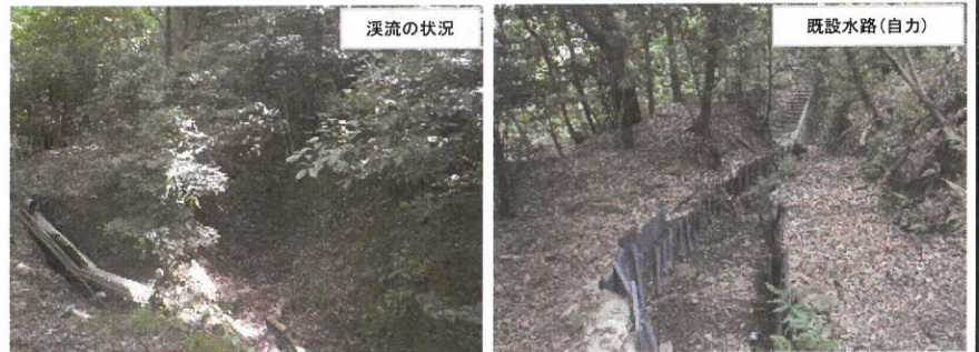
② 治山ダム工下流の状況
