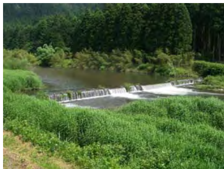
⑤北堰堤 (河床安定のための床固め。魚道が無く遡上困難である。)
