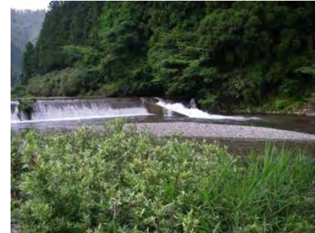
②上江和堰堤 (堰の落差が大きく、遡上不可。魚道は機能していない。堰下流に土砂が堆積している。)
