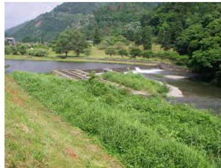
③中堰堤 (魚道は設置されているが、平常時は水量が少なく遡上不可。出水時など水量増加時には遡上可能。突出型のため遡上魚は魚道入口を見つけれず堰直下流に迷入している。)
