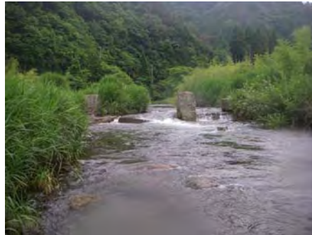
①伊藤谷堰堤 (現在は使われていないと思われる堰で破損している。段差があるため遡上の障害となっているが遡上は可能。魚道は設置されているが、水は流れていない。)
