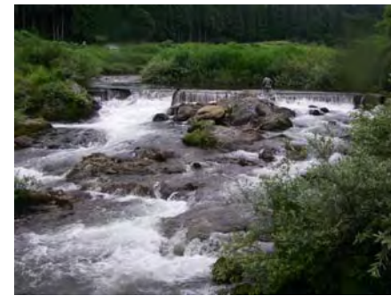
⑦大滝堰堤 (堰の落差が大きく、魚道もないため、遡上困難である。)
