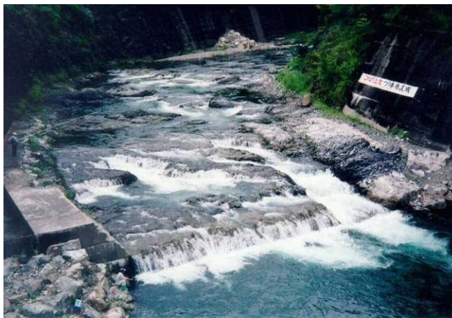
既設堰堤の部分撤去による遡上改善事例（北川・高知県）
