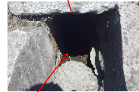
出口のU字側溝に流れていない
