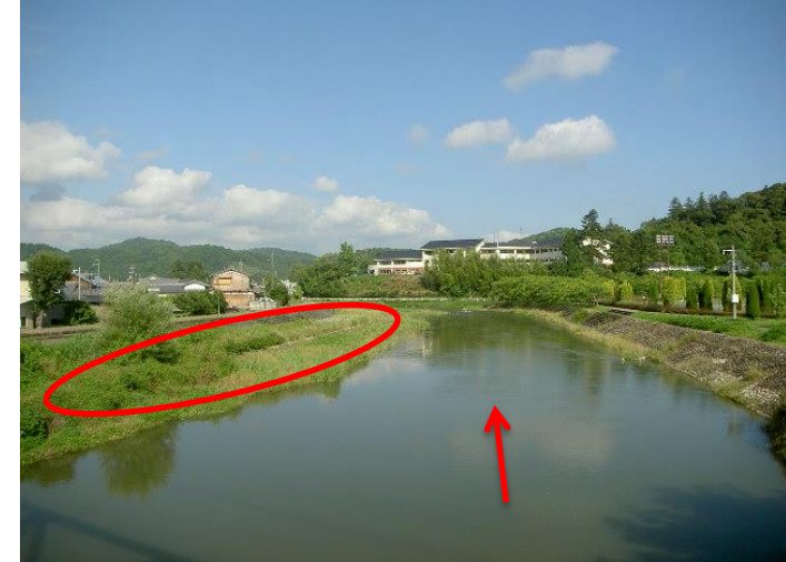
○土砂堆積状況
