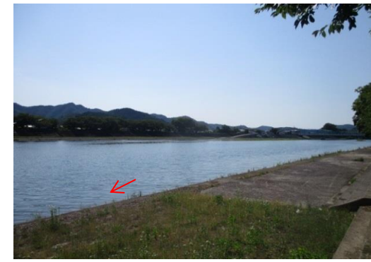
左岸側親水公園より
