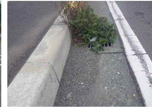
街渠樹の状況
