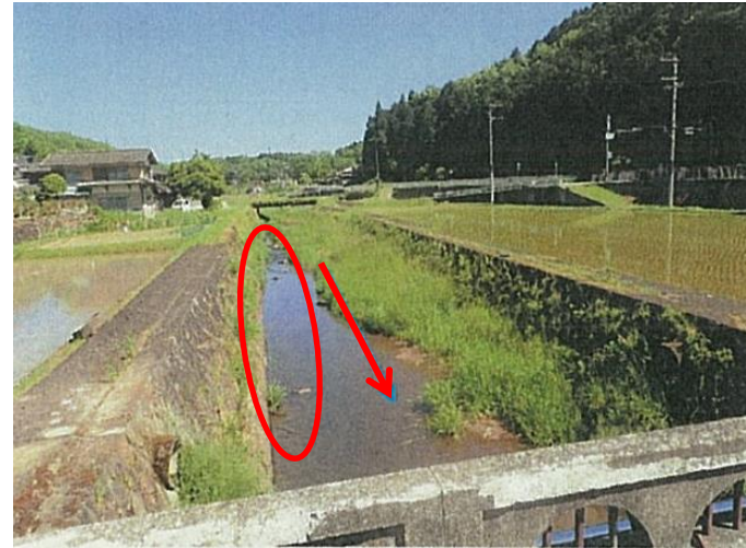
河床整正により護岸基礎を保護する
