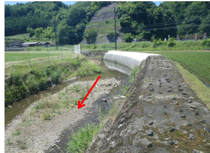
河床整正により護岸基礎を保護する
