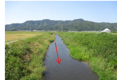
農道橋上流側
