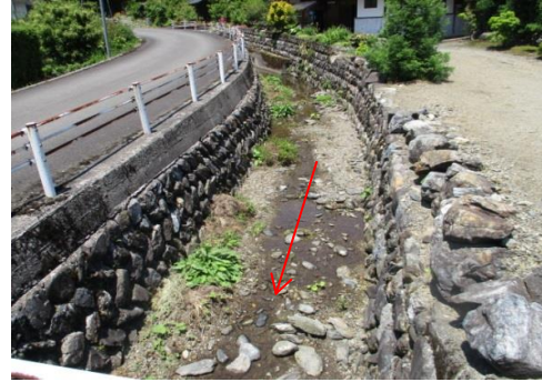
市道橋上流側 上流部は水の流れがみられる
