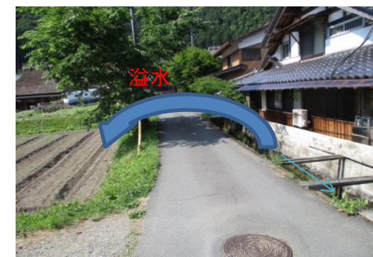
浸水箇所と逆流要因の排水路
