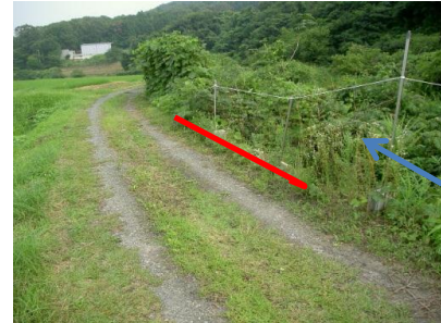
護岸の崩壊による管理用通路への影響
