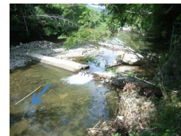
提案箇所上流端の土砂堆積
