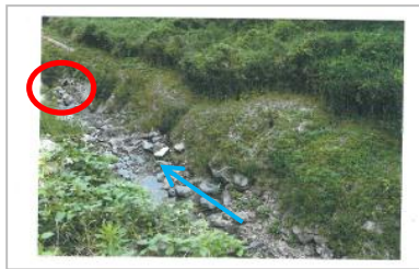
下流 石積みの破損
