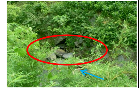
下流 石積みの破損
