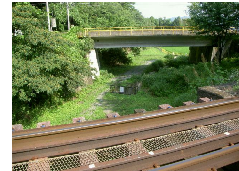
堤内地の状況
