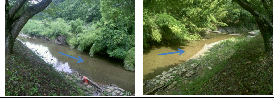
上流では護床工が無い。 提案箇所下流(落差工) 右岸法尻に木工沈床
