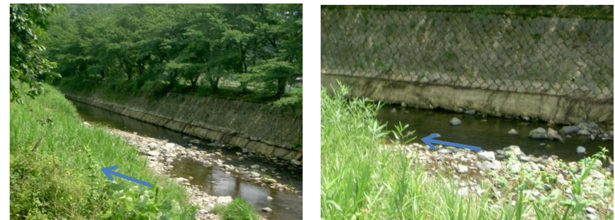
上流では護床工が無い。 提案箇所下流(落差工) 右岸法尻に木工沈床
