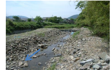
上流端を下流から
