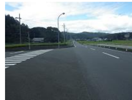
法面状況(起点側撮影)
