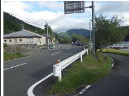
起点側から撮影
