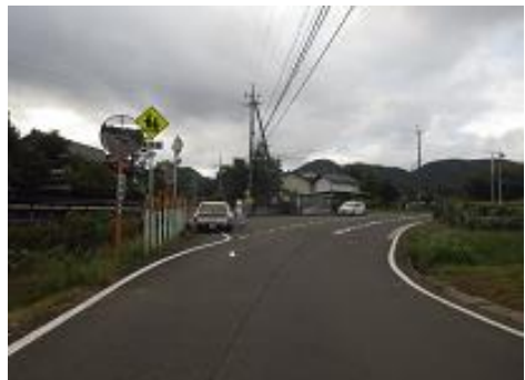
起点側から撮影
