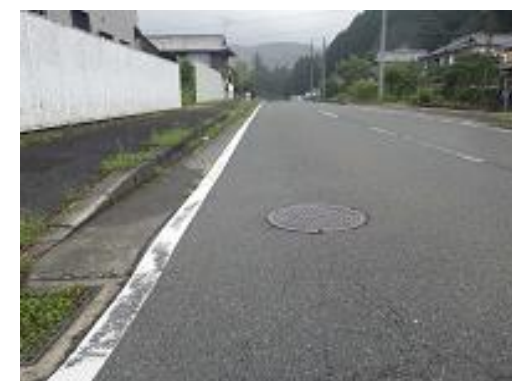
終点側マンホール周辺状況
