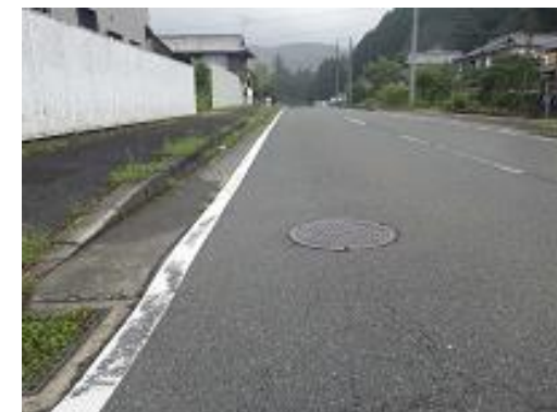
起点側マンホール周辺状況
