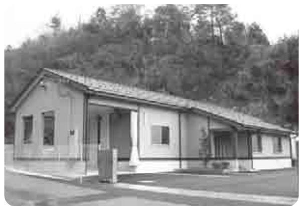
完成した猪・鹿肉処理施設
