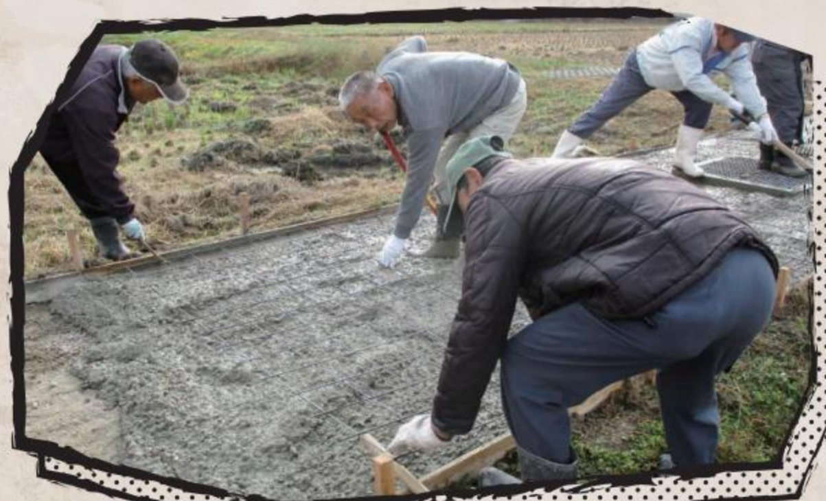
農道の舗装作業
